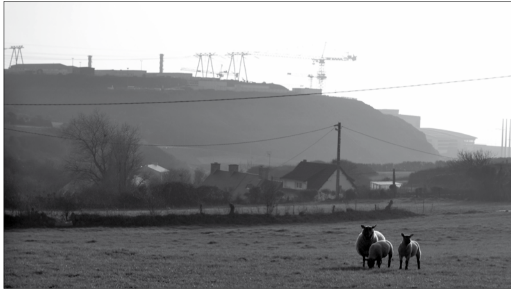
VUE SUR LE CHANTIER EPR DE FLAMANVILLE. PHOTOTHÈQUE ROUGE/ALICE D
