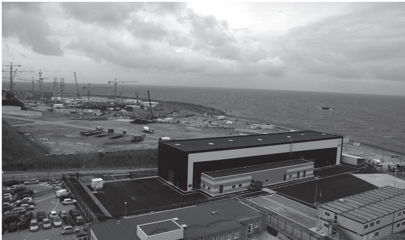
Flamanville, le 27 mars 2009. Chantier de la centrale nucléaire EPR. (PHOTOTHÈQUE ROUGE/FRANCK HOULGATTE)
